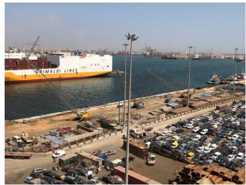
施工中の写真（第三埠頭全景、2020年3月）
